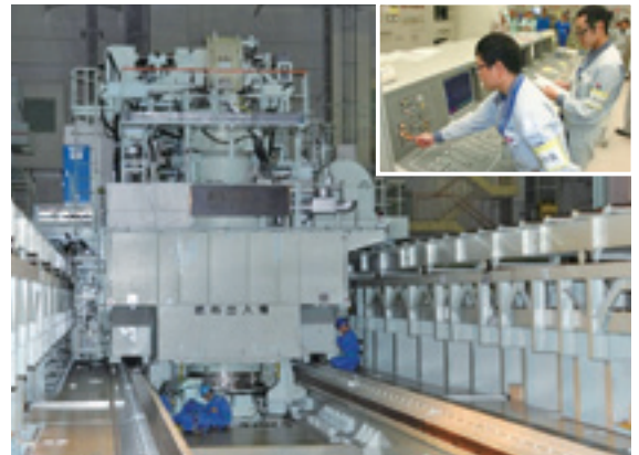
(左)燃料出入機 (右上)燃料取出し作業を行う操作員
